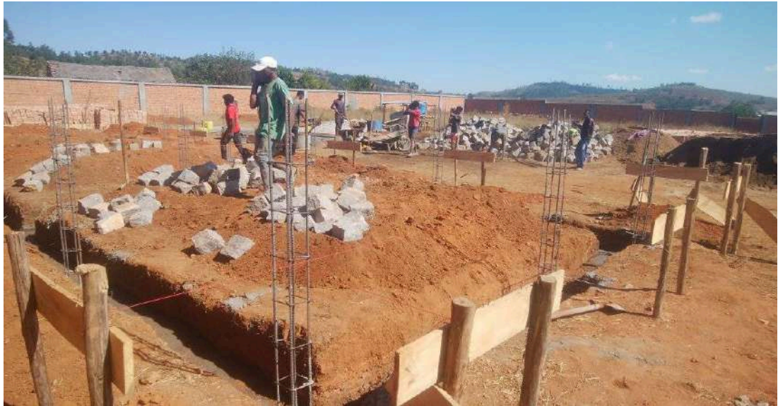
Arrivée sur le chantier des moellons
