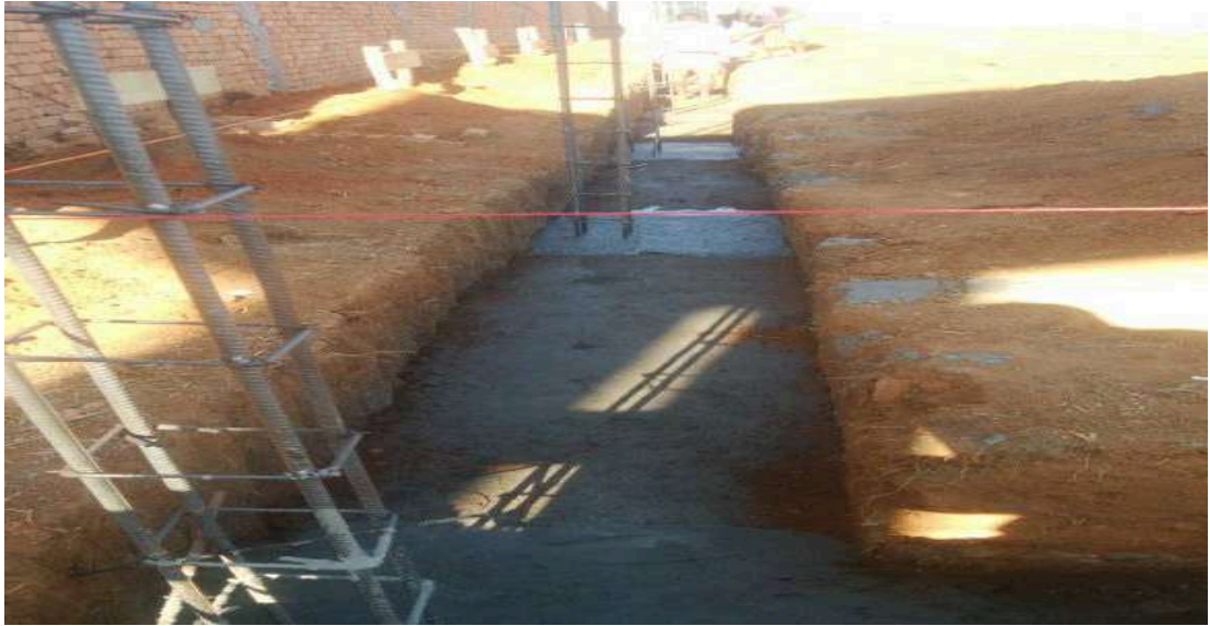
Coulage du béton de propreté et pose des premières armatures
