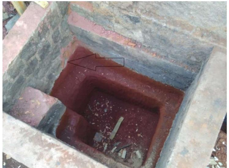
Nous découvrons par surprise, ayant demandé à notre gardien d'aplanir le terrain afin de couler la dalle en béton qui supportera l'incinérateur, une fosse d'enfouissement des déchets, anciennement recouverte par un monticule de terre. Nous allons pouvoir nous en servir afin de jeter les cendres dedans, super ! Pour cela, nous avons commencé par lui rajouter un mètre de profondeur en plus. Sur la photo, la flèche montre où s'arrêtait la profondeur initiale
