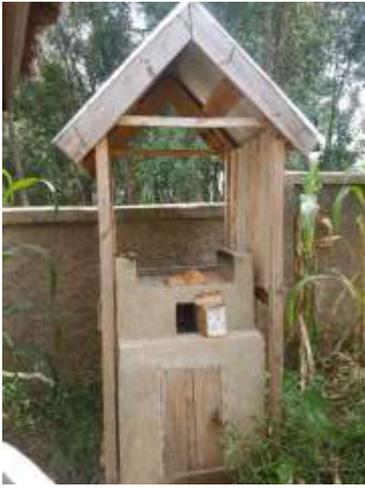
Autre bricolage, la fermeture partielle de l'abri du « **fatepera** » (foyer de cuisson) près du kiosque ; celui-ci n'était pas utilisé jusqu'à présent en raison notamment de l'abri insuffisant entraînant la « contamination » de la « **koba aina** » (farine nutritionnelle) par des poussières et débris. Ceci étant fait, le kiosque et le « **fatepera** » sont maintenant utilisés régulièrement ; il reste cependant quelques problèmes « d'ergonomie » à résoudre pour permettre son adoption définitive.
