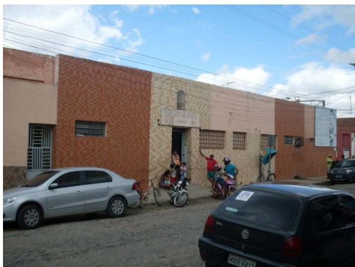
Façade de l'entrée principale
