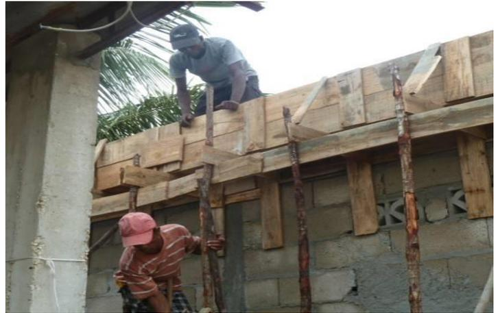
*Les poutres et les chèneaux sont terminés ; on va poser les solives qui vont recevoir la charpente.*
