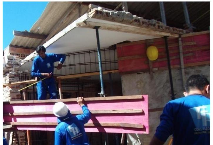
Le chantier prend de l'altitude : les efforts sont permanents pour installer les ferrailles très lourdes, monter les poutres à la bonne hauteur, porter en haut de l'échelle les seaux de mortier à la chaîne pour couler les planchers le plus rapidement possible.
